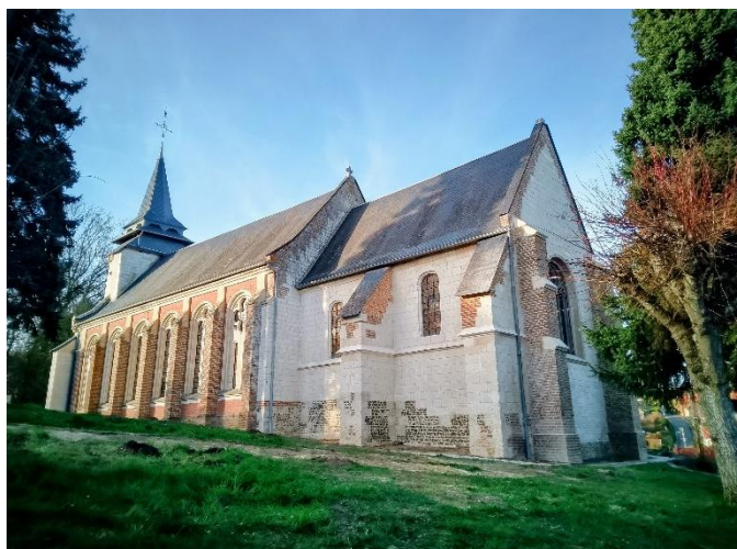
Travaux extérieurs du chœur de l'église terminés
