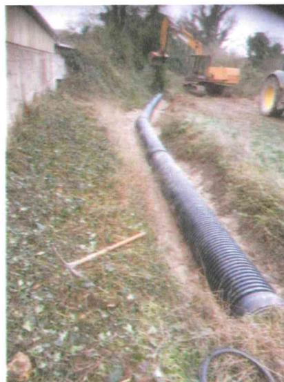
Dans le cadre de l'évacuation des eaux pluviales, mise en place de drains par le propriétaire avec sa grue
